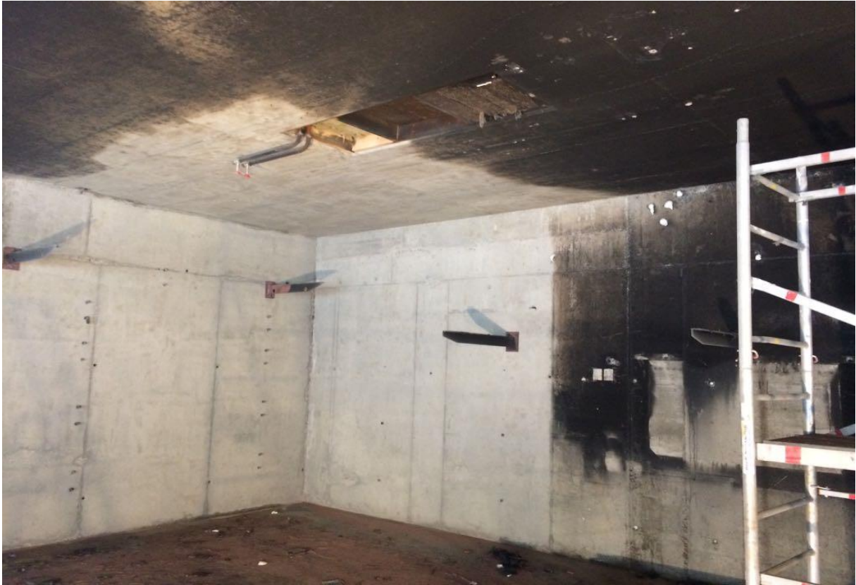
Fotos nach der Brandschadensanierung Betondecken und Wänden
